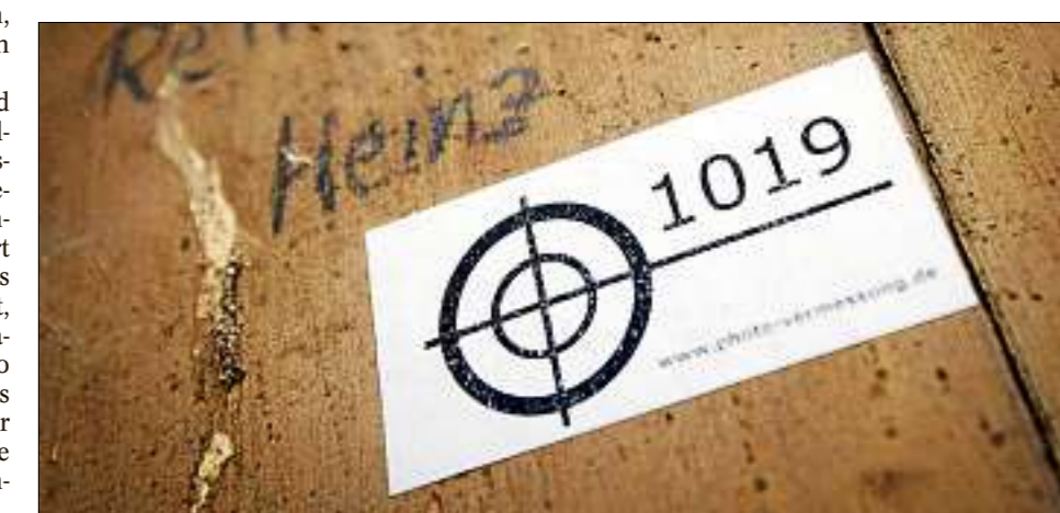
Bevor mit den Sanierungsarbeiten begonnen wurde, musste die Kirche in allen Dimensionen akribisch vermessen werden. Die vielfach zu findenden Zeichen sind Messpunkte.
