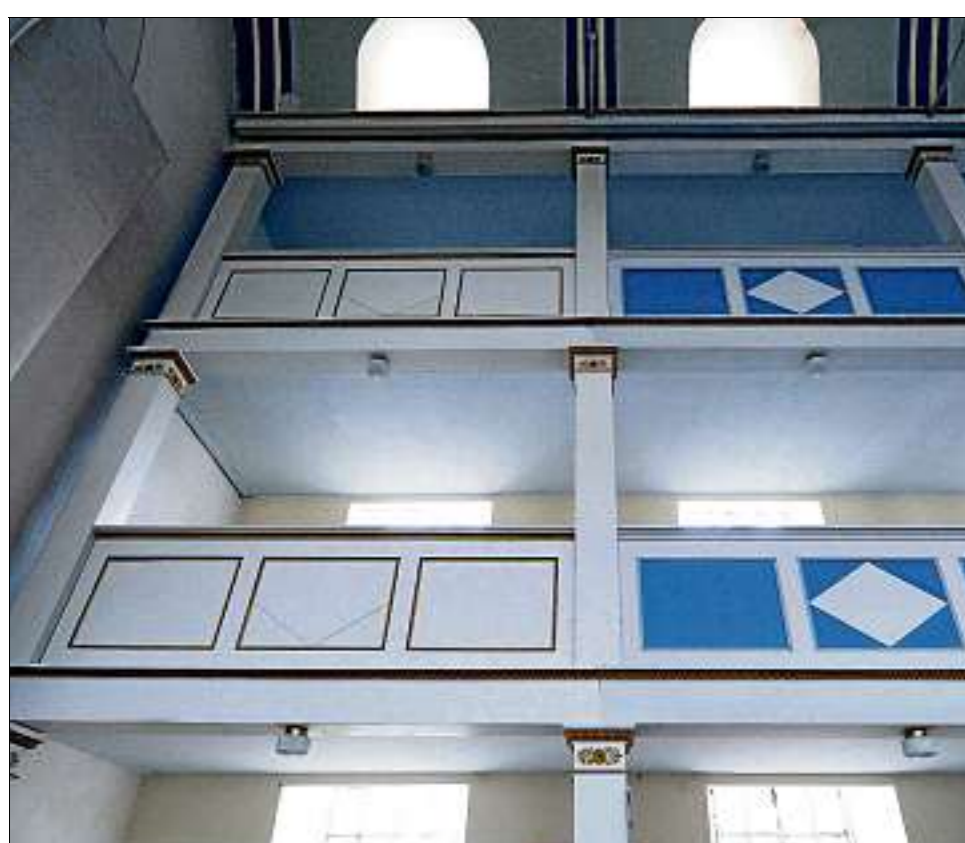
Musterhaft ist im linken Sektor zu sehen, wie die Kirche zu Coudrays Zeiten ausgemalt war und wie sie wieder werden soll. Der Blaukontrast ist in DDR-Zeiten gesetzt worden.
